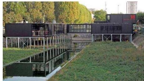
Construit sur une ancienne écluse, le centre se dresse sur des pilotis, à cheval entre les deux bords du canal. Des passerelles relient le bâtiment aux deux rives. De plus, un bassin de rétention des eaux de ruissellement a été mis en place.
